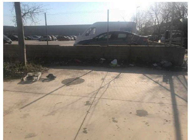
la piera Apunte de foto-7 Mar 25, 2019 at 3:45pm
